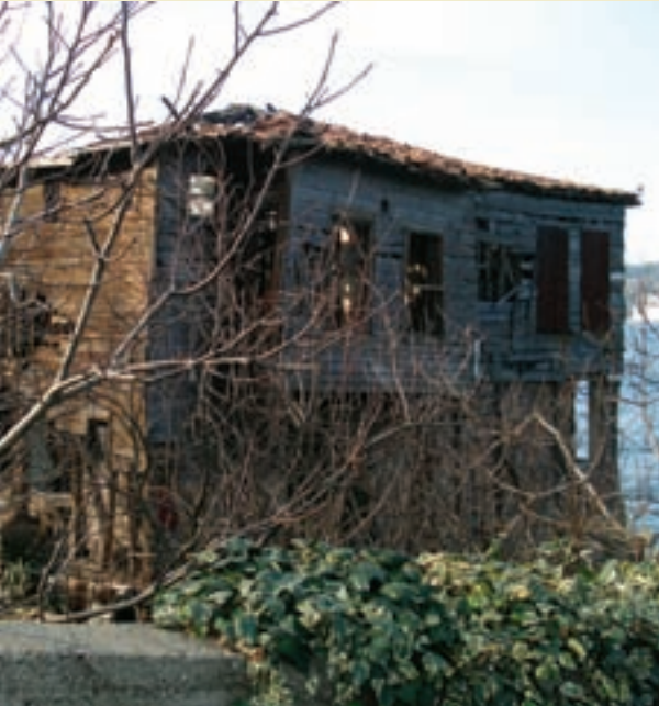
İhale kapsamında uygulaması gerçekleştirilen 689 Ada 7 Parseldeki Köprülüzade Ahmet Vakfından Bahçeli Ahşap Sahilhane'nin uygulama öncesi ve sonrasına ait fotoğrafları.
