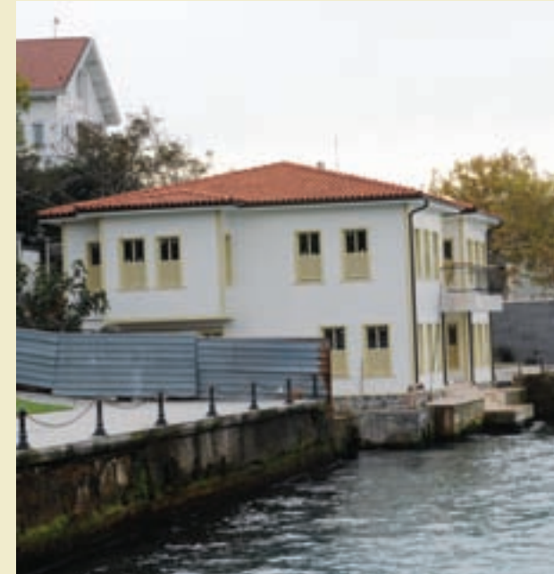
İhale kapsamında uygulaması gerçekleştirilen 689 Ada 7 Parseldeki Bahçeli Ahşap Sahilhane'nin uygulama sonrasına ait fotoğrafı.
