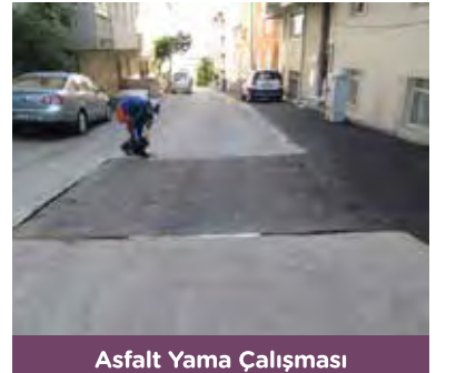
Asfalt Yama Çalışması
