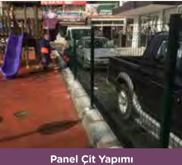
Panel Çit Yapımı
