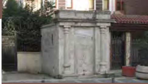
472 ADA 30 PARSEL BULGURLU KÖYÜ ÇEŞMESİ
