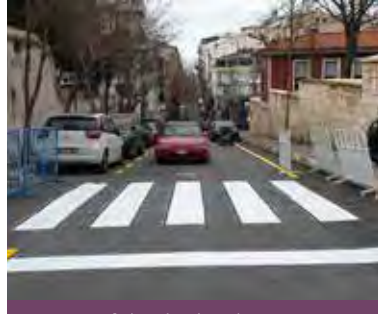
Asfalt Çizgi Çalışması
