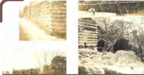
430 ADA 7 PARSEL ŞEREFABAD KASRI SU DEPOSU VE MUTFAĞI
