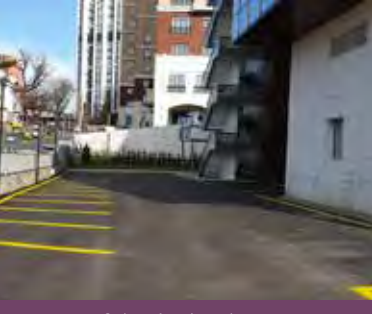
Asfalt Çizgi Çalışması
