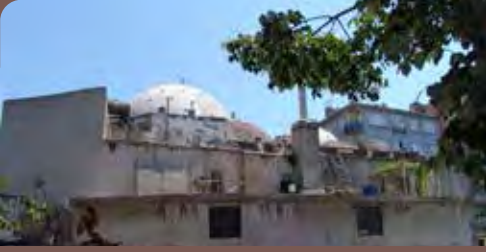
180 ADA 38-39-40-41-42 PARSEL ÇİNİLİ HAMAM
