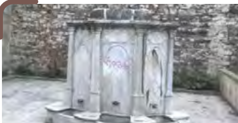
1702 ADA 65 PARSEL ÇEŞME
