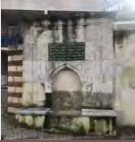
388 ADA 14 PARSEL HATİCE SULTAN ÇEŞMESİ
