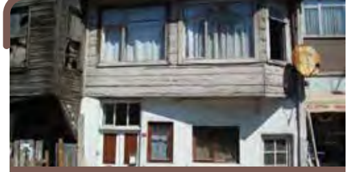
209 ADA 25 PARSEL TESCİLLİ YAPI
