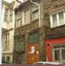
401 ADA 5 PARSEL TESCİLLİ YAPI
