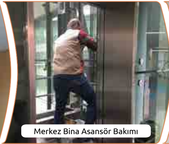
Teknik Servis Çalışmalarımızdan Örnekler
