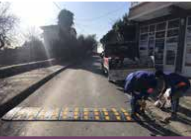
Hız Kesici Set Montajı Çalışması
