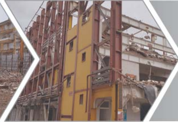
Katlı Otopark Yıkım Çalışması
