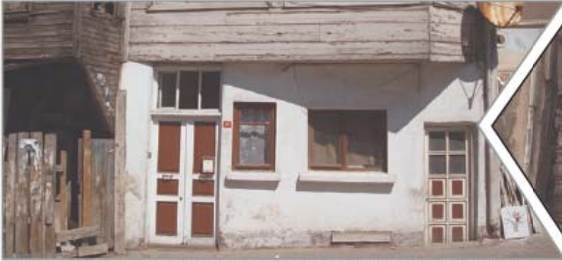
209 Ada 25 Parseldeki Tescilli Yapının Rölöve, Restitüsyon, Restorasyon, Statik, Tesisat, Elektrik Projesi (Rölöve ve Rsetitüsyon Projesi Koruma Kurulu tarafından onaylanmıştır.)
