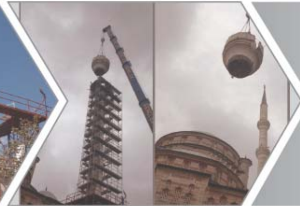
Ferah Merkez Camii Yıkım Çalışması
