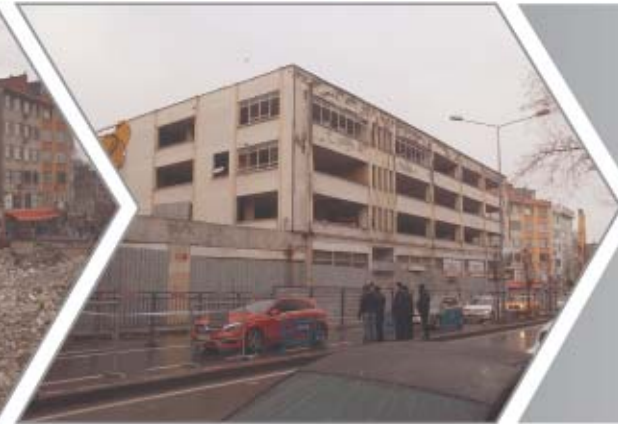
Vergi Dairesi Yıkım Çalışması
