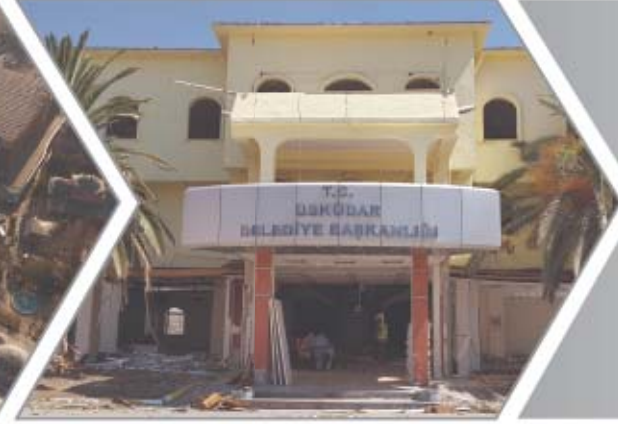
Eski Belediye Binası Yıkım Çalışması
