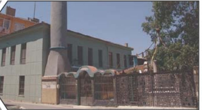
175 Ada 50 Parseldeki Fenai Ali efendi Tekkesi (Camii) Haziresi ve Türbesi, Rölöve, Restitüsyon ve Restorasyon Projesi (Koruma Kurulu Onay Aşamasında)
